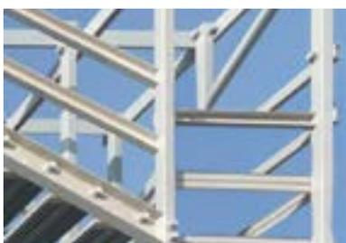
■ Structure et plancher en PRV (matériau non conducteur)
